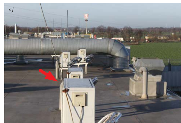
Rys. 32. Zwody pionowe (a) i przewód odprowadzający prąd piorunowy do uziomu bezpośrednio przymocowane do klimatyzatorów i anteny SAT.
