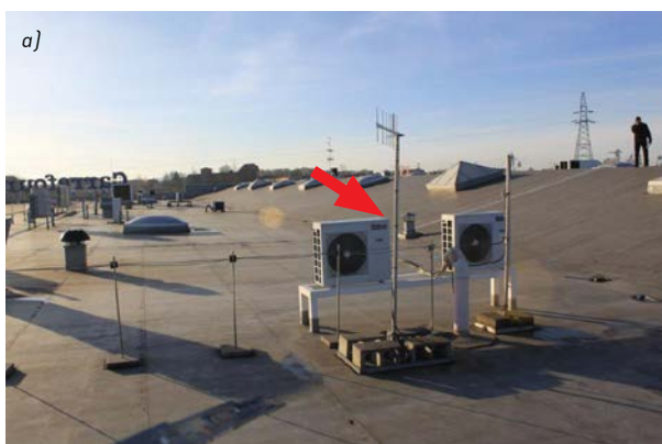
Rys. 30. Antena telewizyjna i klimatyzator (a) oraz kamera CCTV (b) umieszczone wyżej niż zwód poziomy na dachu.
