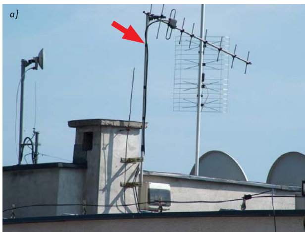
Rys. 29. Antena telewizyjna (a) i Wi-Fi (b) zamontowana wyżej niż zwód pionowy na dachu.
