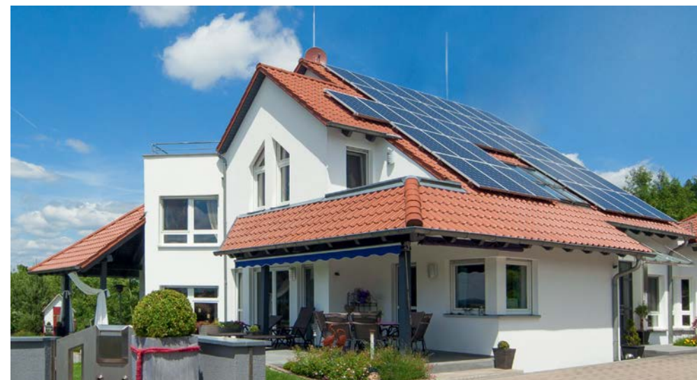
Rys. 26. Obiekt budowlany z panelami fotowoltaicznymi chroniony przed wylądowaniami piorunowymi.
