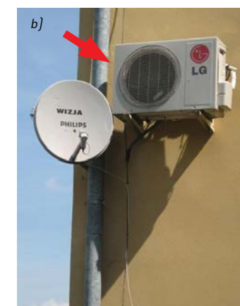
Rys. 32. Zwody pionowe (a) i przewód odprowadzający prąd piorunowy do uziomu bezpośrednio przymocowane do klimatyzatorów i anteny SAT.
